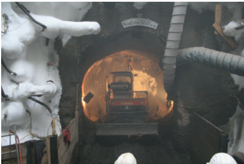
Bild 3: Vortrieb mittels Minibagger
